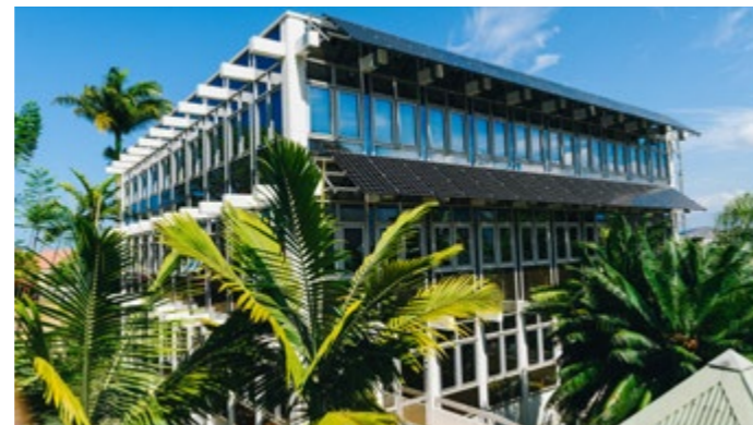
Depuis mai 2020, le siège social de la SIC est équipé de panneaux photovoltaïques.
