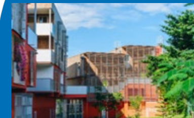
Nahoata à Païta 19 logements
