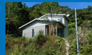
Dracaena à Poindimié 10 logements
