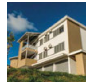
Résidence Santal : Petite opération mixte réhab / neuf, ECO / aidé, et innovante car 2 logements adaptés aux malvoyants.
